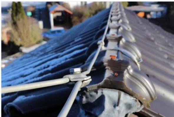
Figure 1 : Point de raccordement d'un réseau de paratonnerre
