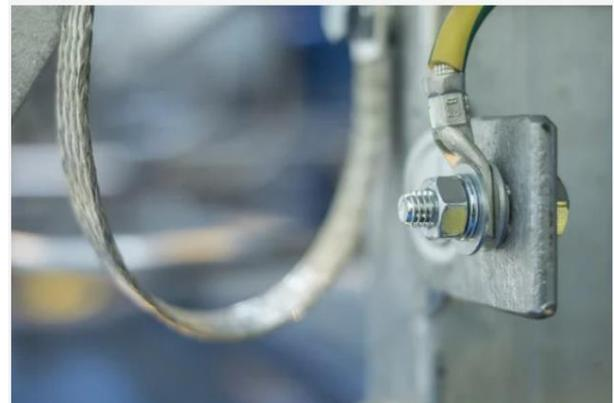
Figure 2 : Point de mise à la terre d'une installation industrielle
